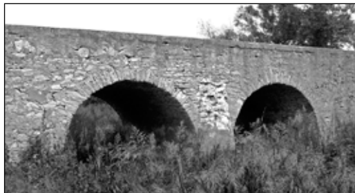
Leomlott jégtörő a taktaharkányi Harangod-patak kétnyílású kőboltozatán (2015).
