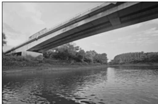
Ez volt az első szabadon szerelt feszített vasbeton hidunk. (fotók: Gyukics Péter)
