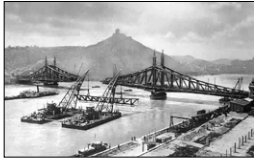
A Szabadság híd Gerber csukló eleme. (fotó: FÖMTERV)
