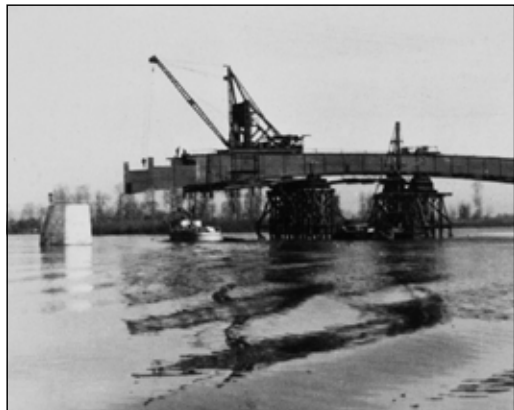
A főtartó gazdaságos szerelése az újjáépítés során. (fotó: dr. Domanovszky Sándor gyűjteménye)
