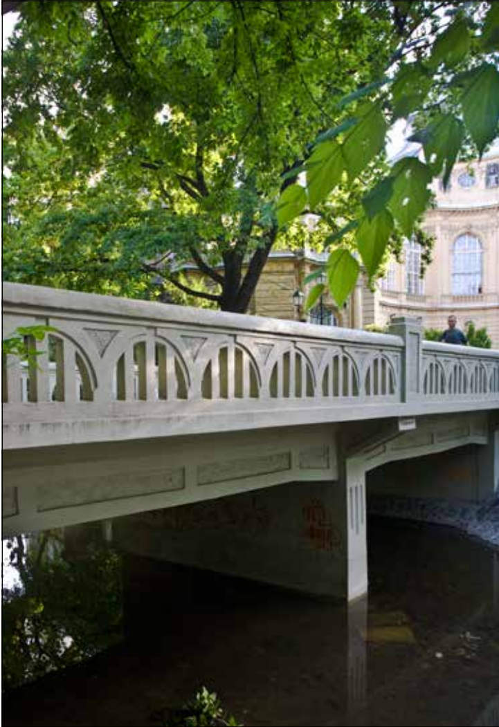
Budapest, a Városligeti tó feletti közúti híd. (Kétnyílású, alul bordás vasbeton műemlék. 2015)
