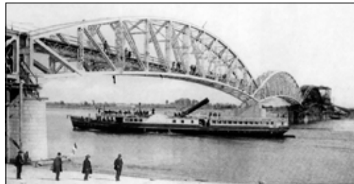
A Budapest alatti első Duna-híd.
