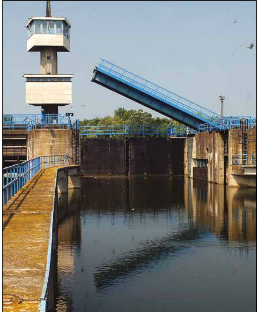
A Sió torkolati műtárgya emelhető hídjával (2004).
