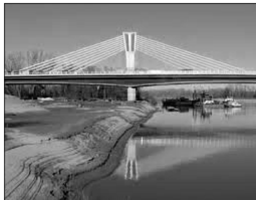
M 43 Móra Ferenc Tisza-híd. (fotó: Pont-TERV Zrt.)
