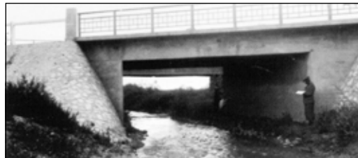
A Gaja-patak híd 1935-ben. (fotó: Kiskörösi Közüti Szakgyűjtemény)
