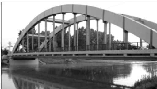
Sárvár merevbetétes Rába-hídja megerősítés és felújítás után
