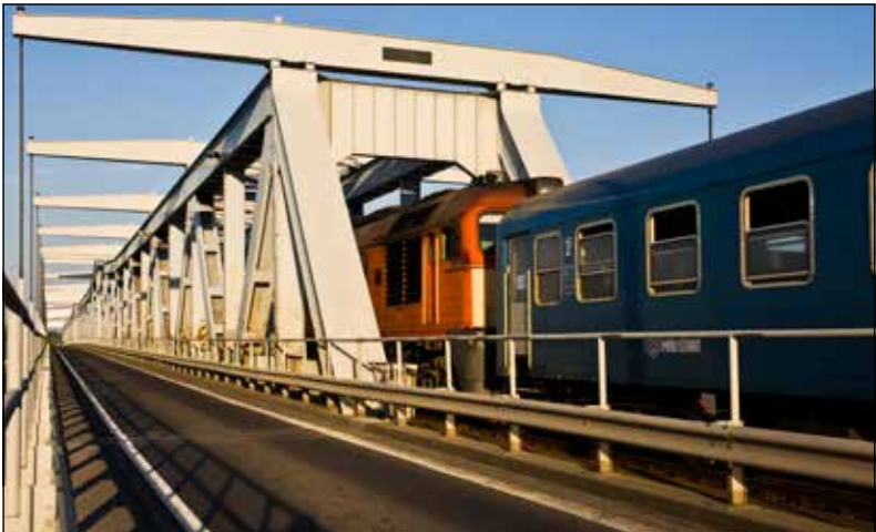
Baja, a Türr István Duna-híd közepén a vasúti, két oldalán a közúti forgalom halad (2007).
