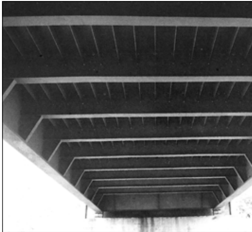
Ortotróp pályalemez Laskó-patak híd
