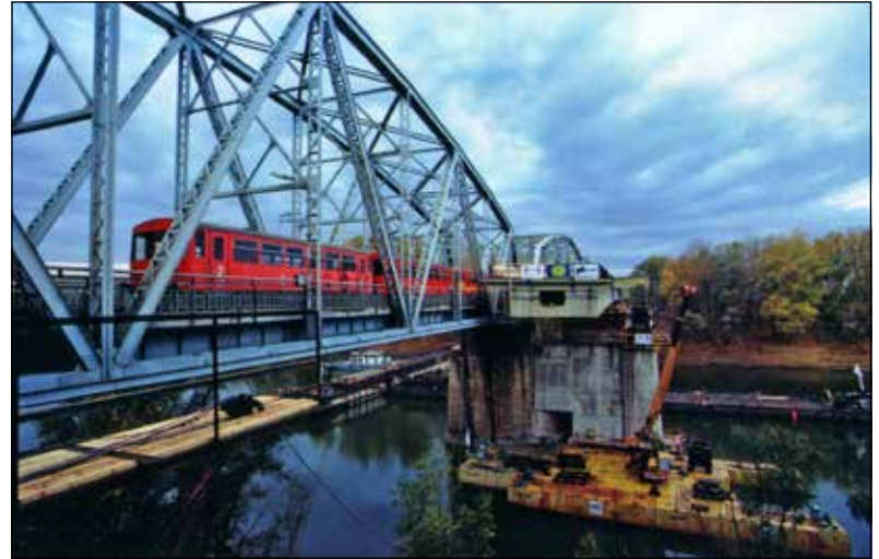
Tiszaug, 1999. A közúti híd acélszerkezete betolás közben a pilléren. Az 1929-ben átadott Tisza-híd még vasúti-közúti közös használatban.
