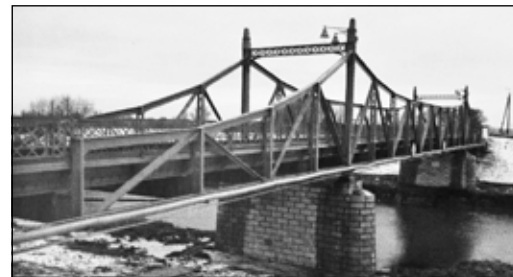
A híd a felújítás után (fotó: Magész Acélszerkezetek)
