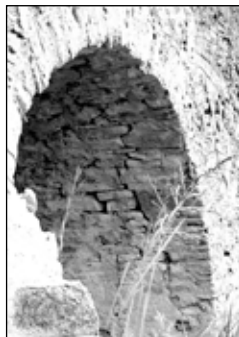
Repedés a taktaharkányi kőhíd boltozatán. A sérülés egyik okozója túlterhelés lehet (2015).
