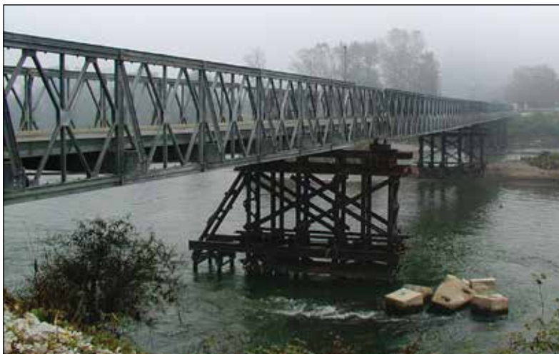
Mabey&Johnson típusú fémhíd Dobojnál (Bosznia-Hercegovina). Építette a Magyar Műszaki Kontingens.
