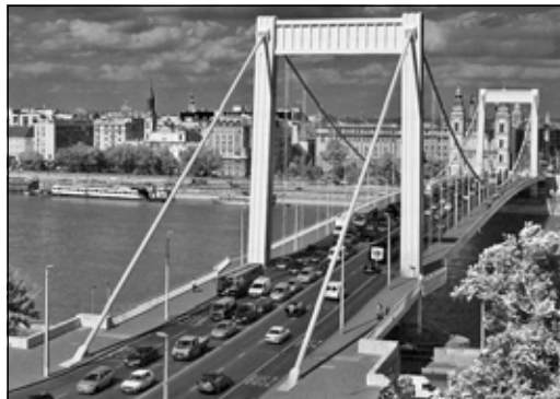
Erzsébet híd, kábelhíd (fotó: Gyukics Péter)
