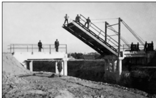
A Sükösd - korpádi nyitható híd, 1929. (Sági Jenő gyűjteményéből)
