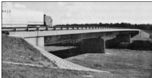
1990-ben új, szakaszos előretolási technológiával építették ezt a hidat.
