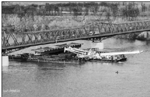
A szekszárdi Duna-híd záróeleme úsztatása közben a Dunaföldvári híd alatt 2002 őszén. (fotó: Gyukics Péter)
