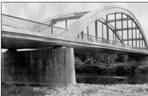
Az Alsóberecki Bodrog-híd látványa a partról. (fotó: Borsod-Abaúj-Zemplén Megyei Közútkezelő)
