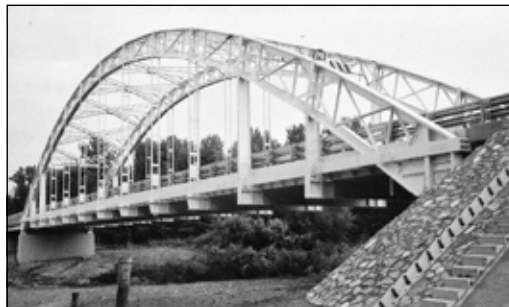
A Marcaltői acél ívhíd a 2012-es felújítás után. (fotó: KÖZGÉP)
