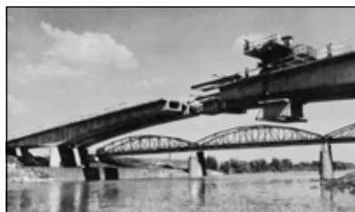
A készülő Kettős-Körös híd. (fotó: Hídepítő Vállalat)
