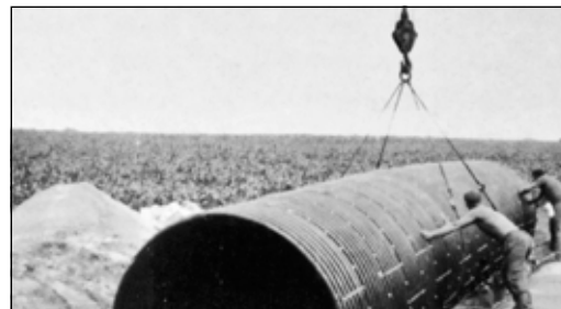
A velence-csákvári úton 1972-ben épített 2x2,4 m nyílású hullámosított acéllemez hídja. (fotó: dr. Tóth Ernő)
