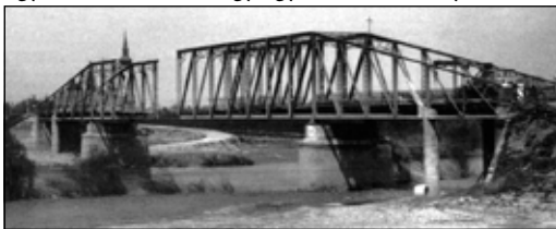
Körösladány Sebes-Körös hídja elbontás közben. (fotó: Hídépítő Vállalat)
