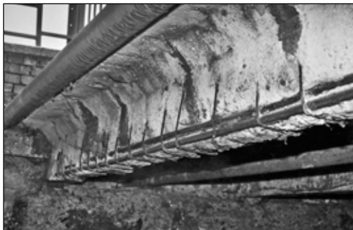
Vasbeton híd főtartójának korrozíója
