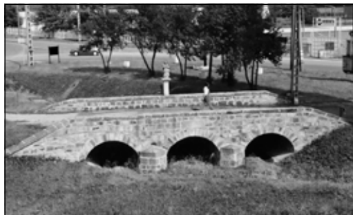
A gyalogos híddá vált Lókos-patak-híd. (fotó: Makai Tamás)
