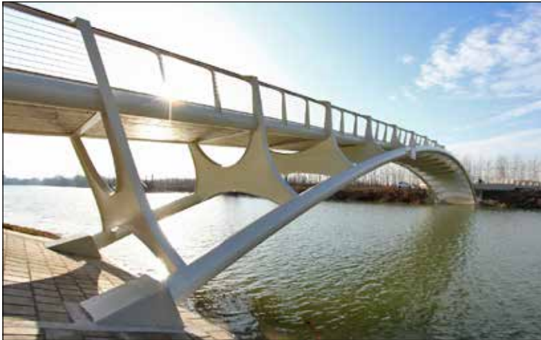
Bajai Petőfi-sziget és Pandúr-sziget között gyalogos- és kerékpáros híd. Tervező: Speciálterv Kft. Kivitelező: Közgép – Strabag Konzorcium
