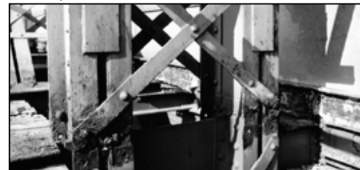
Súlyos korróziós károsodás a Szabadsághídon, 1985-ben.
