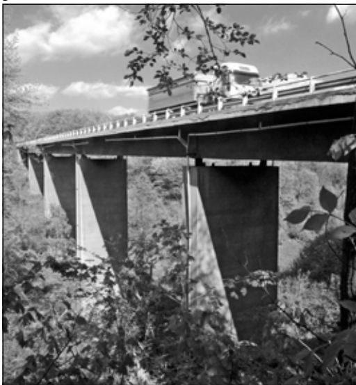
Bolond úti völgyhíd hídgerendáit a helyszínen készítették el. (fotó: Gyukics Péter)
