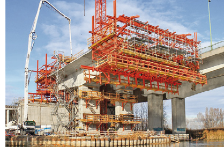
M0 Soroksári Duna-ág-híd – VARIOKIT rendszerrel szabadon betonozott technológia
