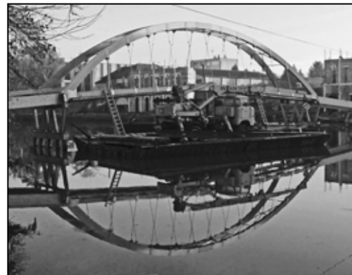
Szarvas, az új fa gyaloghíd építése végén 2010-ben. Hazánkban ez az első fából készült korsárfüles ívhíd. (fotó: Lorászkó Balázs)
