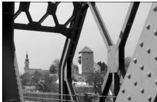
Szegecs a Dunaföldvári Duna-híd szerkezetén. (fotó: Gyukics Péter)
