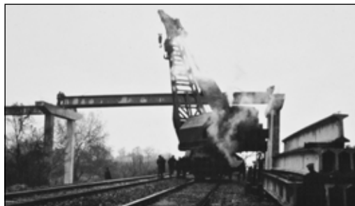
Az első teljes előregyártással készült hidunk építés közben. Gerenda beemelés vasúti gőzdaruval. (fotó: Rigler István)
