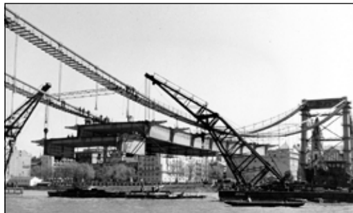
Az Erzsébet kábelhíd építése 1963-ban, állvány nélkül
