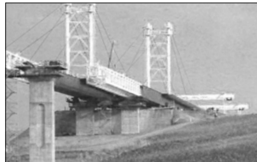
A Szebényi völgyhíd építés közben
