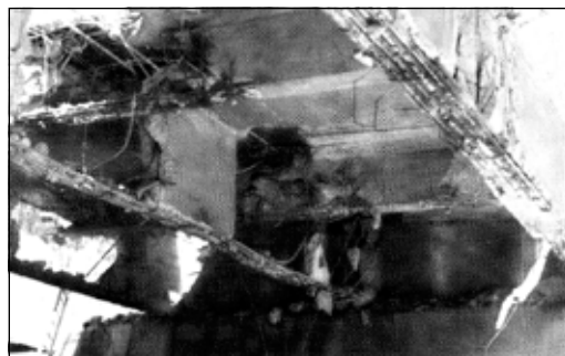
A felrobbantott bordás szerkezet közelről. (fotó: Széchenyi István Műszaki Főiskola)
