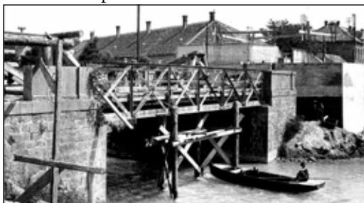
Épül az első siófoki állandó közúti Sió-híd. (fotó: id. Jaczó Győző)
