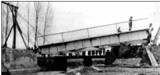
A hídszerkezet helyére emelése, 1950. (illusztráció: Hidak Bács-Kiskun Megyében)
