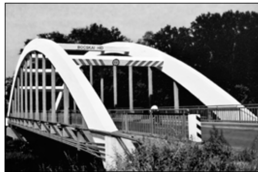
Bocskai alsópályás vasbeton ívhíd. (fotó: Hajós Bence)
