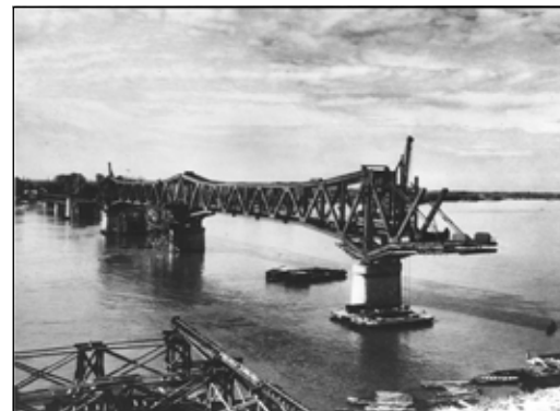
Baja, a Duna-híd újjáépítése 1949.
