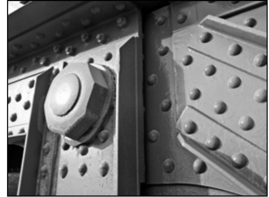
A Szabadság híd Gerber csukló eleme. (fotó: FÖMTERV)
