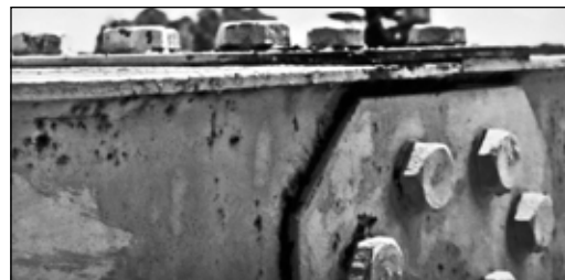
Korrozíó acél hidakon
