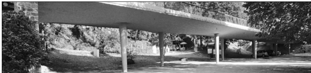
A tűsarkokon álló, könnyed vasbeton híd Tihanyban. (fotók: Gyukics Péter)
