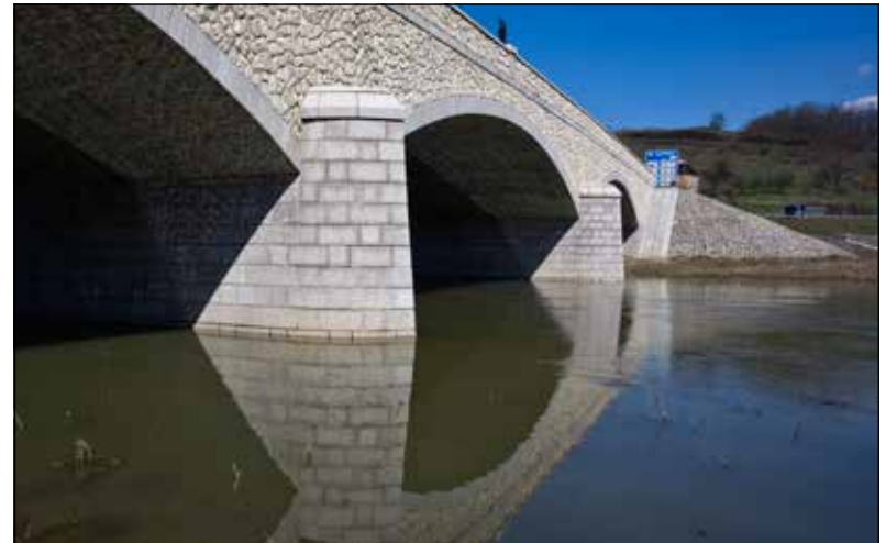
Rárópuszta-Rárós/Rároš magyar-szlovák határ híd az Ipolyon. Jobbra a szlovák oldal. Három nyílású kőborítású vasbeton boltozat (2012).
