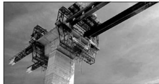
Zöm az egyik pillér tetején, a Kőröshegyi völgyhíd építése során. (fotó: Gyukics Péter)
