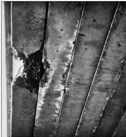
Járműütközés miatt eltört vasbeton hídgerenda
