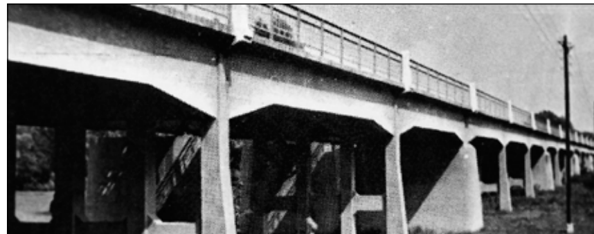
Az Eger-patak-híd fényképe. (fotó: Heves Megyei Közútkezelő)
