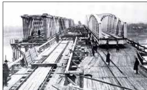
Kisköre, a vasúti Tisza-híd átépítése.
