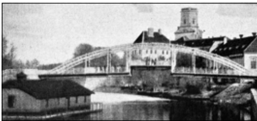
A győri Nagy Rába-híd felemelt középső szakasszal. (illusztráció: Mentés Zoltán gyűjteménye)
