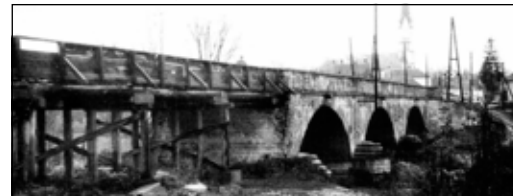
Zalalövő, a Rabok hídja ideiglenes helyreállítása. (fotó: dr. Gáll Imre)
