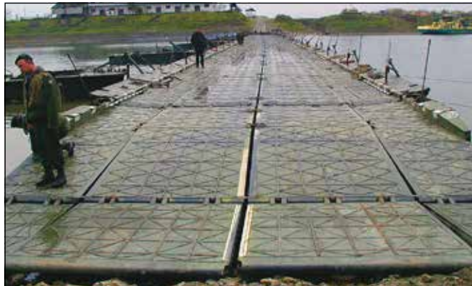
PMP típusú úszó aljazatú híd a Száván. Építette a Magyar Műszaki Kontingens.
