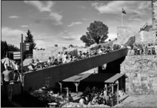
Az egykori fahíd helyére készített mellvédes vasbeton híd. (fotó: Gyukics Péter)
