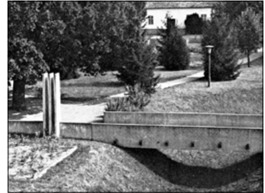
Jelképes vasbeton híd Szigetvár várának felvonóhídja helyén. (fotó: Sugár István)
