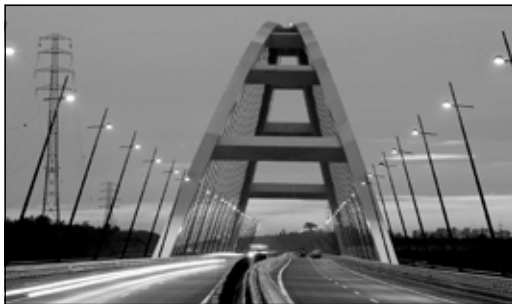
Pentele Duna-híd mederszerkezete, alsópályás acél ívhíd (fotó: Gyukics Péter)
