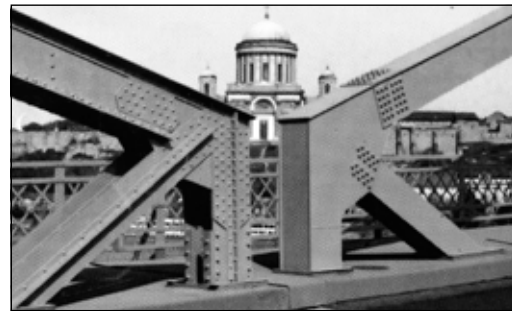
Balra a szegecselt, jobbra az NF csavaros szerkezet a Mária-Valéria hídon, Esztergomban. (fotó: dr. Domanovszky Sándor)
