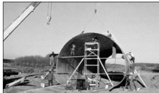
Nagy átmérőjű hullámosított híd szerelése. (fotó: Közútkezelő)
