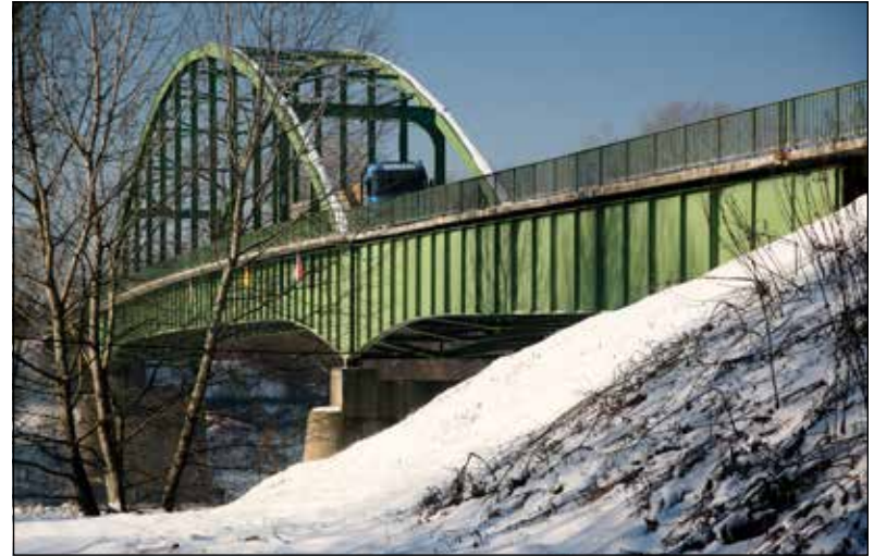
A Vásárosnaményi II. Rákóczi Ferenc Tisza-híd 2004 telén.
