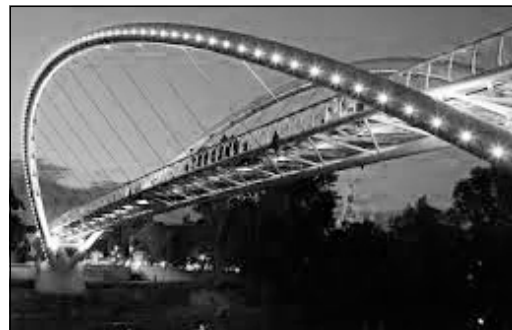
Szolnok, Tiszavirág gyaloghíd a Tiszán. (fotó: Pont-TERV Zrt.)
