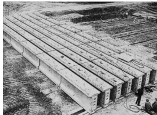
Az algyői típusú hídgerendák gyártása a helyszínen, 1973-ban. (fotó: Hídépítő Vállalat)
