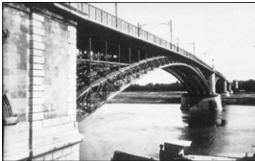
Feketeházy János tervei szerint az Eiffel-cég által épített szegedi közúti híd. (fotó: MÁVAG archívum)
