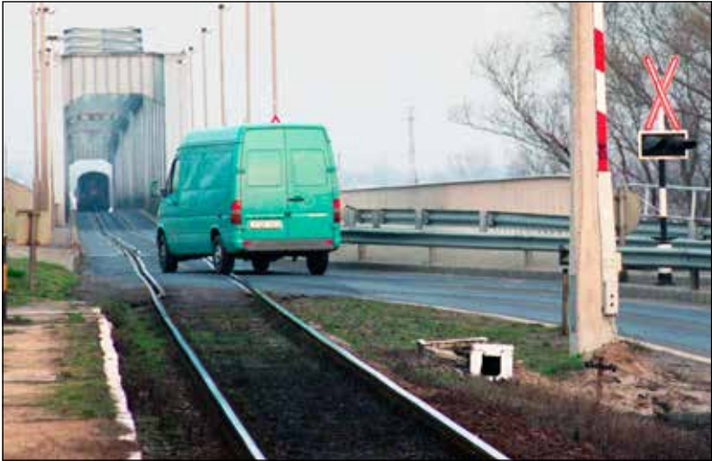
Baja, a Türr István Duna-híd még közös vasúti-közúti használatban (1987).
