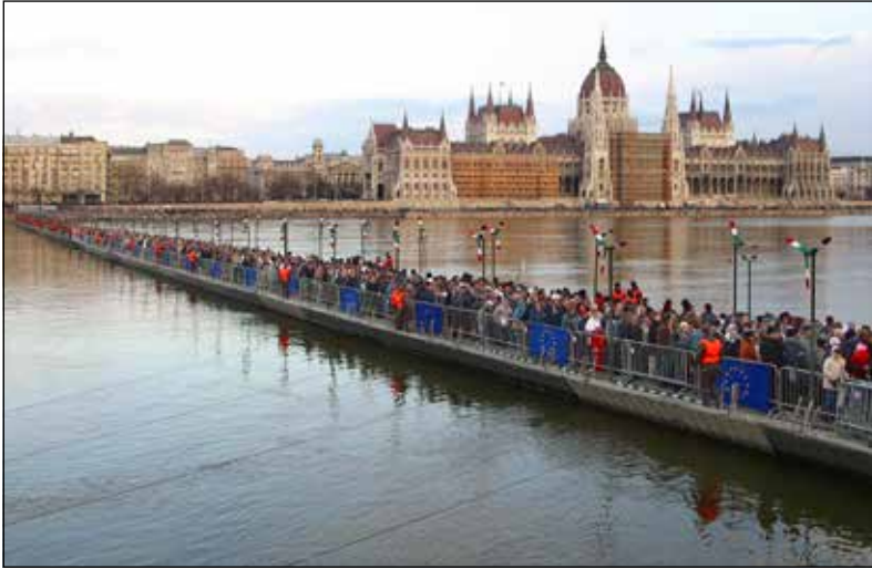
Az Európa ponton híd a Dunán, 2003. március 15-n. (PMP típusú ponton hadihíd.)
