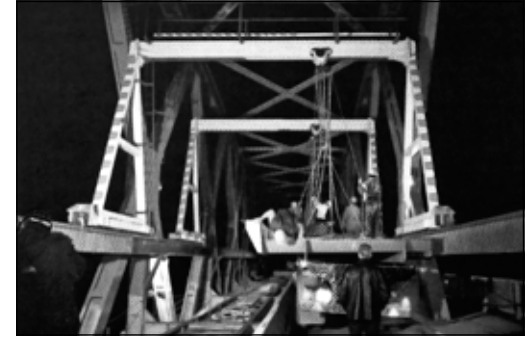
Egy pályalemez egység beemelése Dunaföldváron. (fotó: Rigler István)
